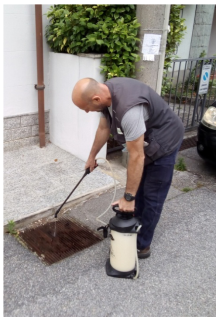
Figura 8, trattamento di un tombino con pompa a mano.
